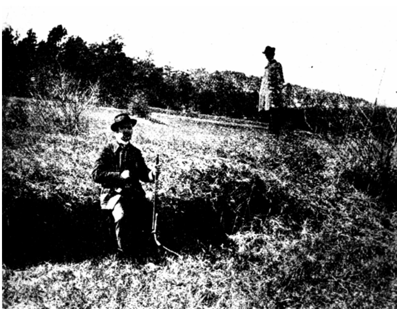
Obr. 4. Jedna z trhlín, ktoré vznikli pri zemetrasení dňa 9.1.1906 v Dobrej Vode.
